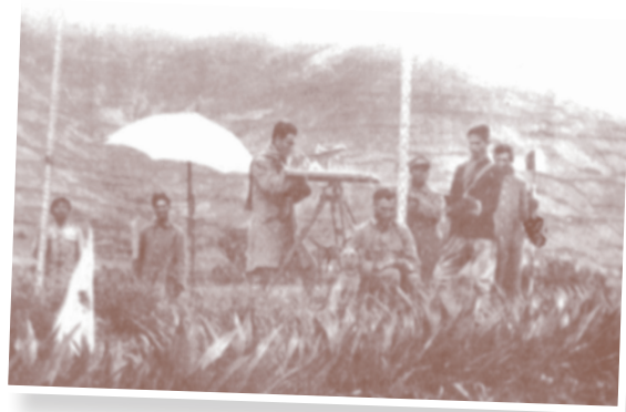
Empleo de la Plancheta para relleno de restitución de fotogrametría terrestre.
