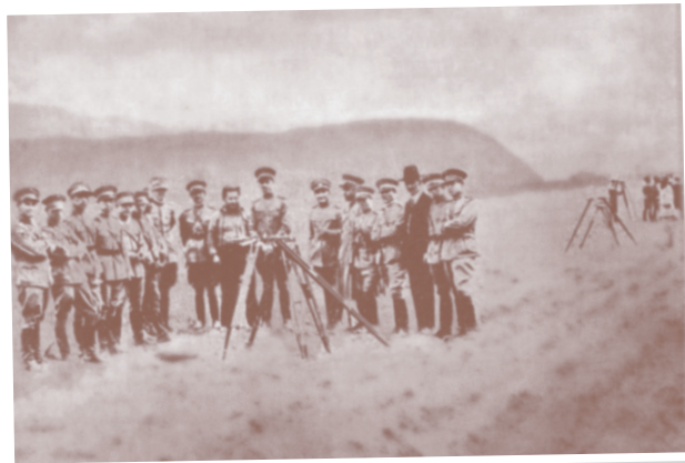
Observaciones realizadas por el personal del Servicio Geográfico Militar con el Altazimut.
